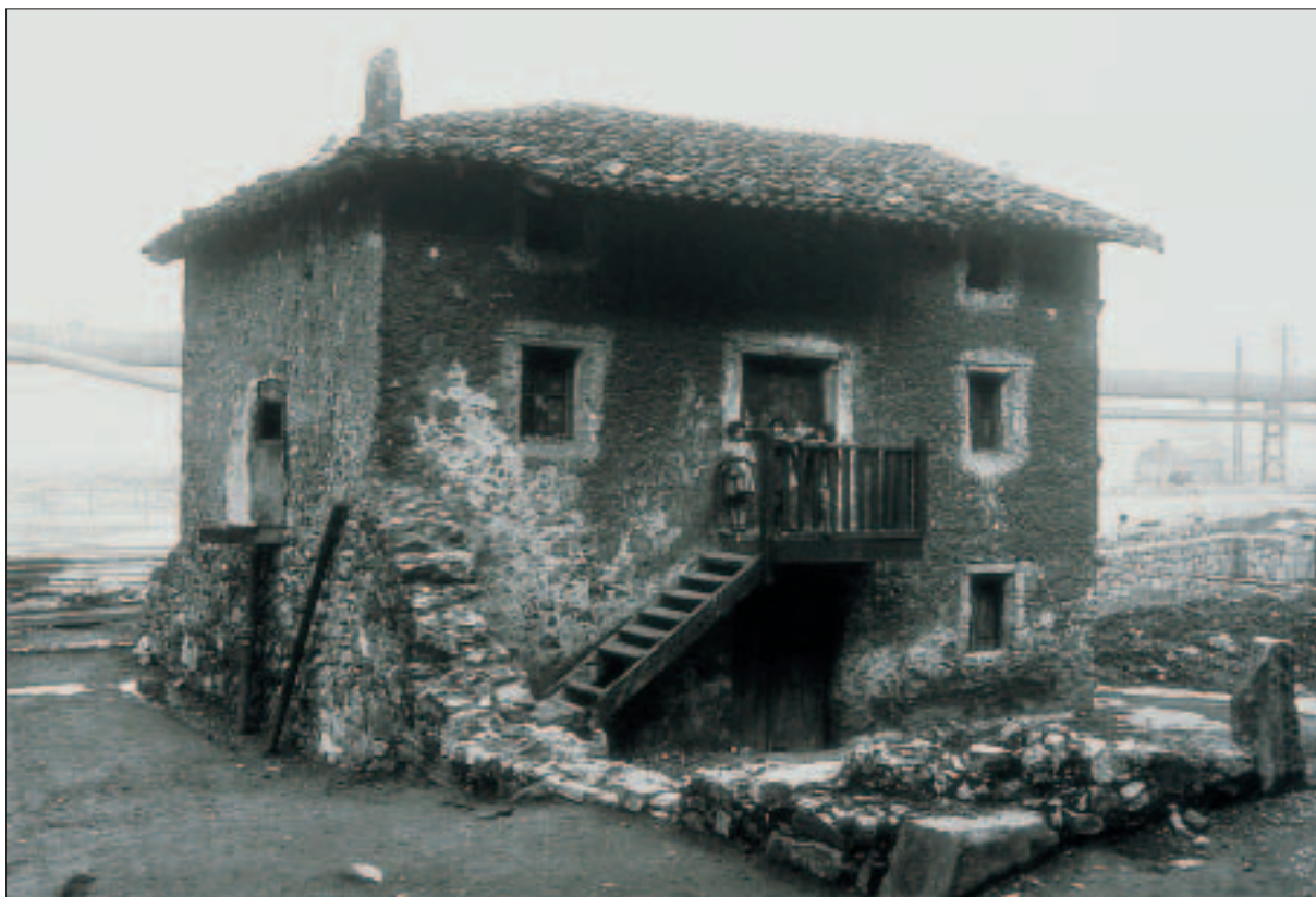
Imagen antigua de un caserío de Beurko en la que se puede observar la escalera de acceso de madera, hoy en día desaparecida.
