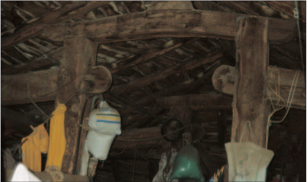
Par de pies derechos del camarote del caserío Gorostiza n.º 7 unidos por un astazaldi. Se observa también la unión con los tirantes mediante espigas pasantes y chavetas.
