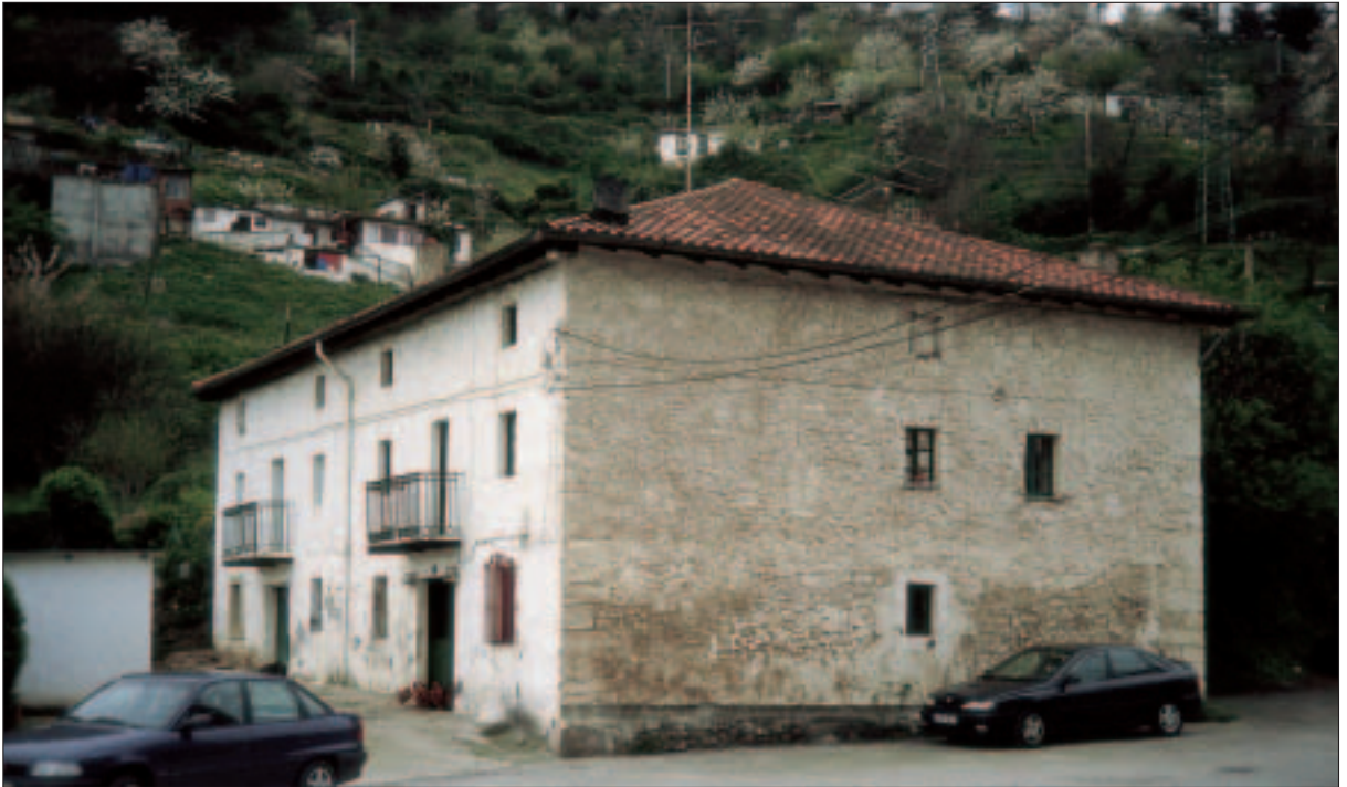
Caserío bifamiliar cúbico Kareaga-Las Carolinas n.º 3-5.
