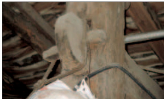
Detalle de la espiga pasante y chaveta del caserío Gorostiza n.º 7.
