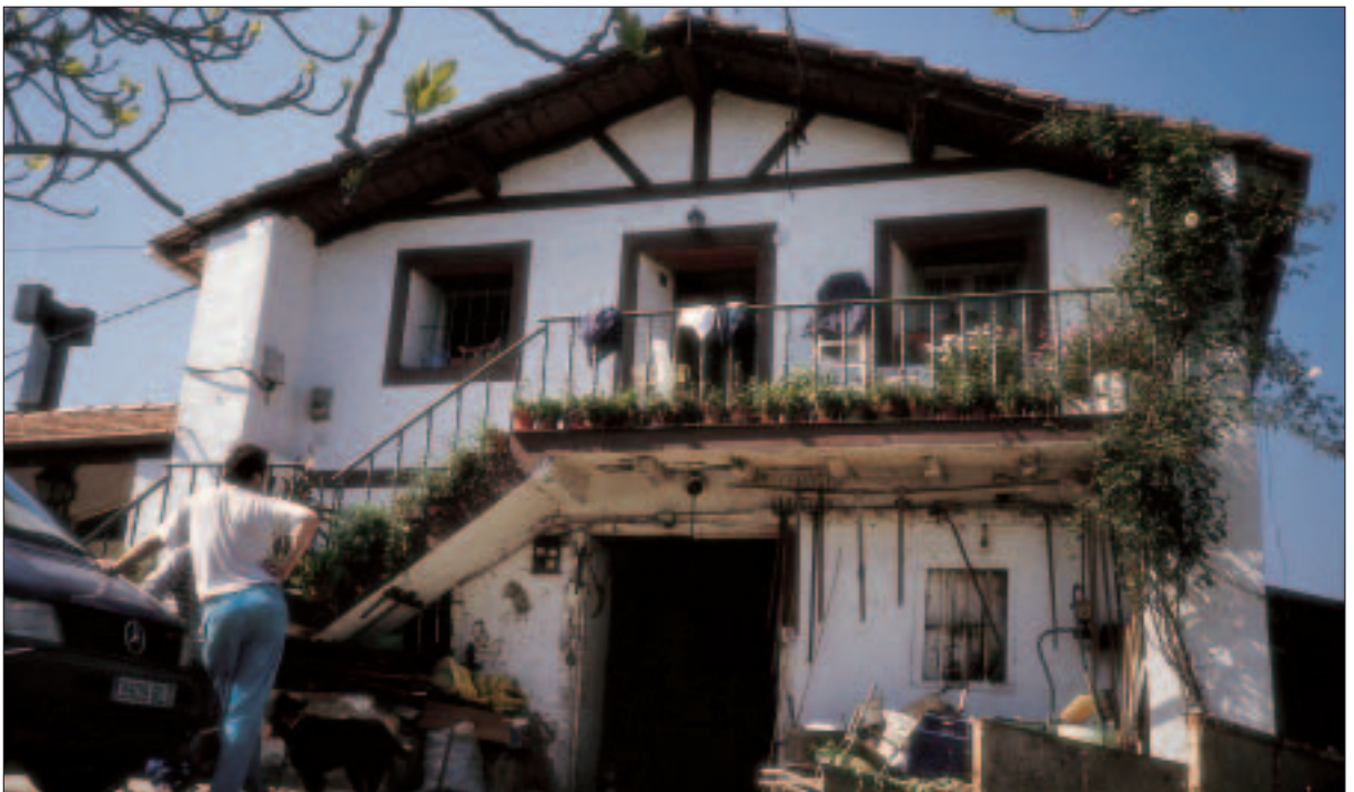
Caserío Oskari a dos aguas con antas y balcón corrido. Se observa el portalón de la cuadra y el patín moderno de acceso al piso noble.
