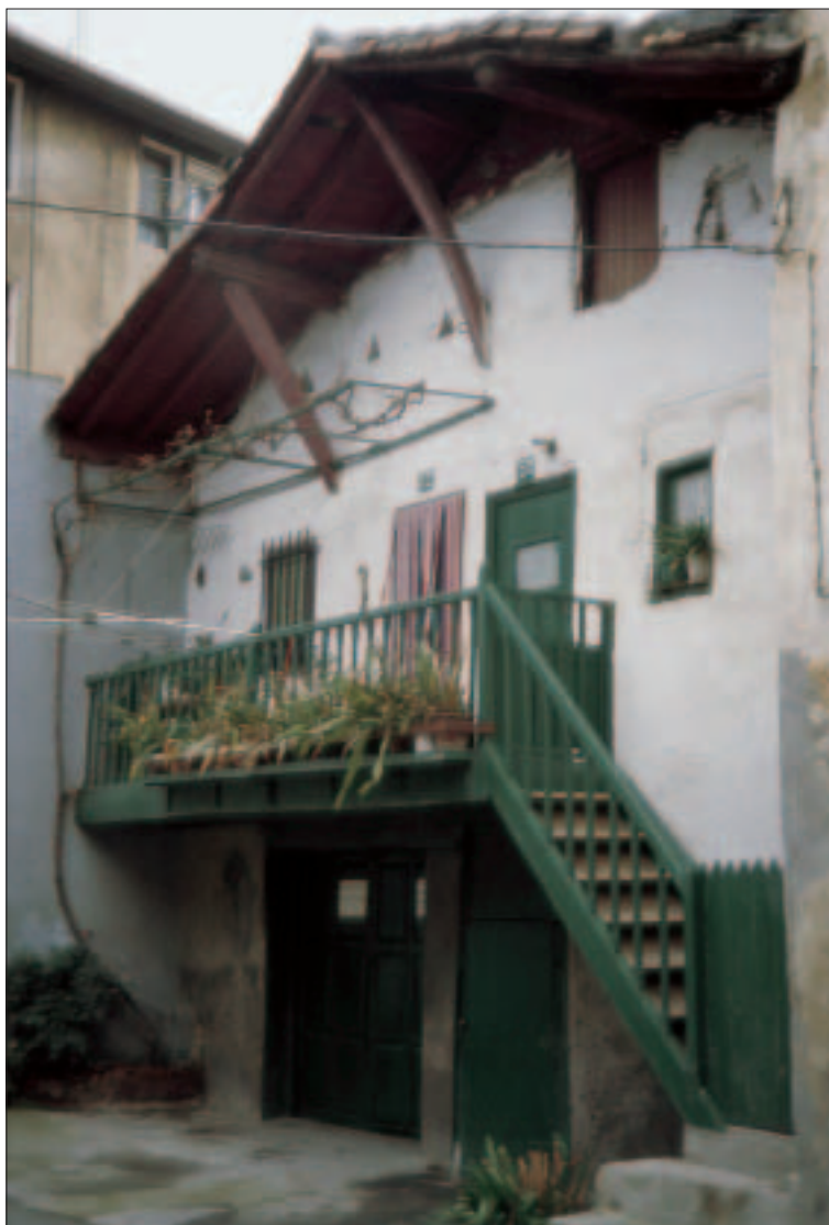
Caserío a dos aguas con patín Retuerto n.º 52-54. Se observa el patín, el balcón, el acceso a la cuadra y los jabalcones que sostienen el alero del tejado.
