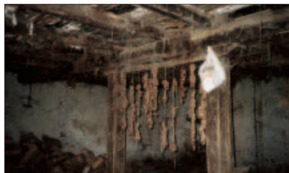
Par de pies derechos de la planta baja del caserío Palacio unidos por una zapata sobre la que se observa la viga carrera y los olivos.
