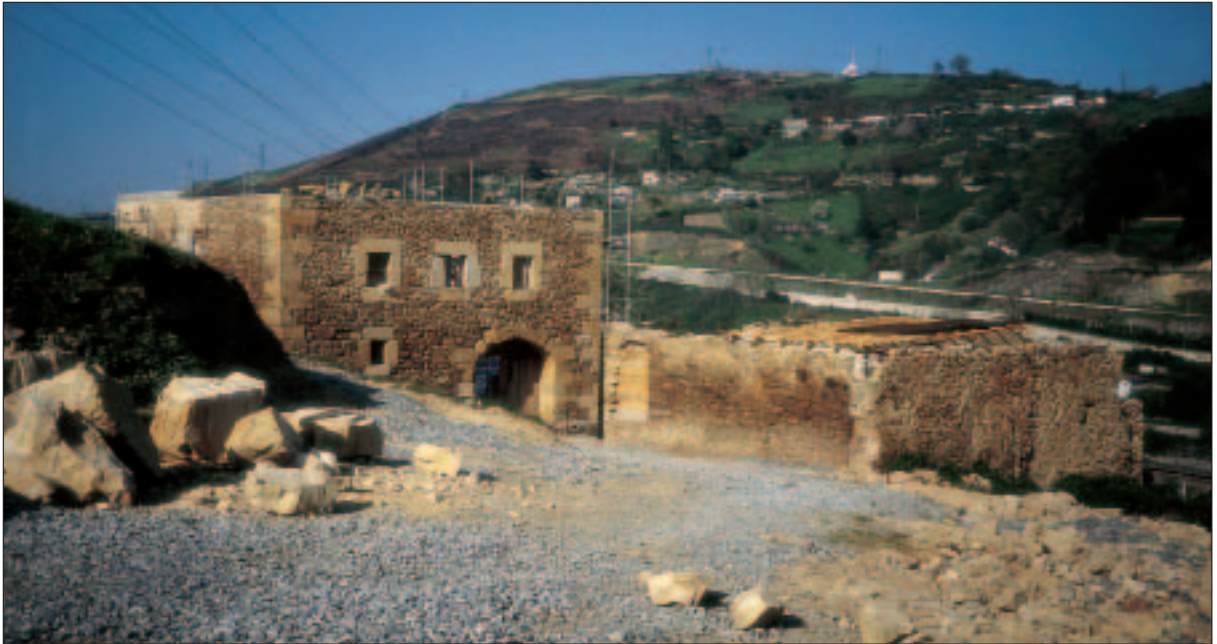
Visión general del caserío Casablanca con el arco de entrada a la cuadra. Junto a él se observa el edificio que acoge la cubera o lugar.
