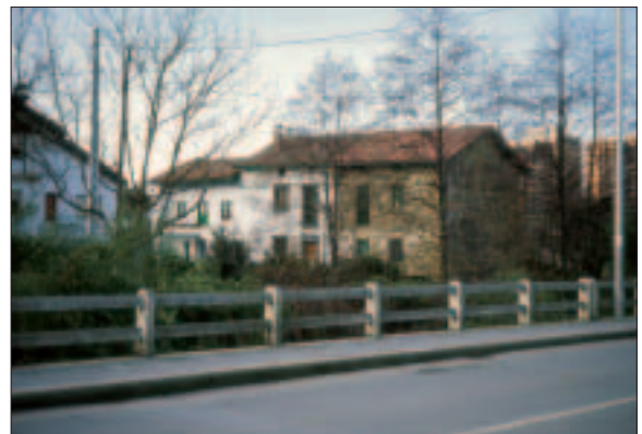
Imagen actual del lugar que debió ocupar el molino y ferrería de Bengolea.
